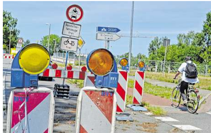
Radfahrer in Huchting haben im Unterschied zu Kraftfahrzeugen freie Fahrt über die Brückenbaustelle im Zuge der Heinrich-Plett-Allee.
