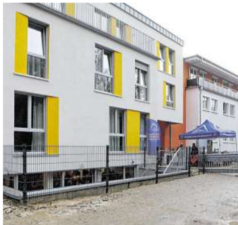
Der Neubau von der Kattenturmer Heerstraße aus betrachtet. FOTO: WALTER GERBRACHT
