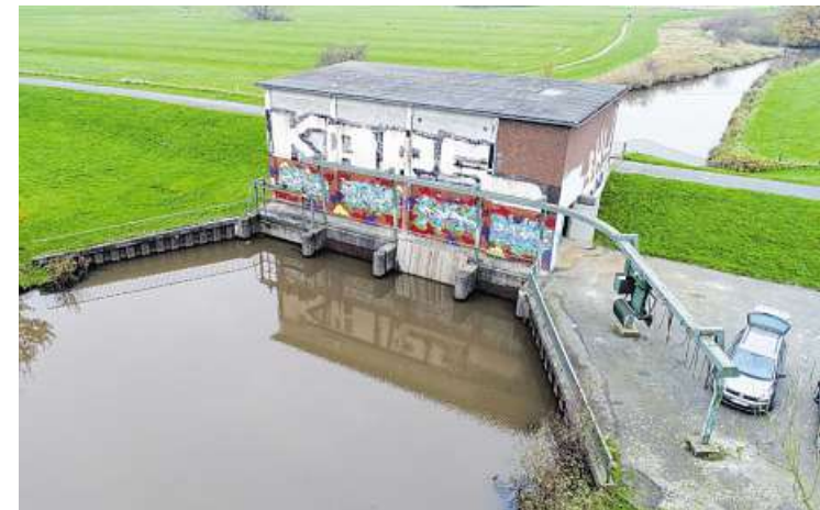
Das Schöpfwerk Nord in Huchting ist großflächig mit Graffiti beschmiert. Zukünftig wird es einzäunt und mit Videotechnik überwacht sein.
